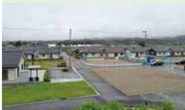
駅西の開発区域を北から望む。災害公営住宅や店舗、診療所（県営）などが建設中
