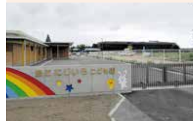
手前が認定こども園。奥が小中学校で中央に給食共同調理場。東側には公営住宅85戸を建設中。
