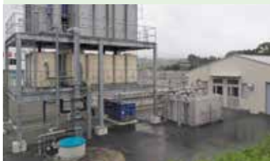
再築された木戸川鮭ふ化場
